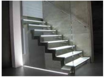
Die offene Treppenkonstruktion mit Glasstufen trägt dazu bei das Licht direkt und indirekt über die 4 Stockwerke zu verteilen.
